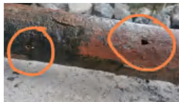
原管道镀锌管
